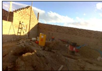
4 Muro de adobe
