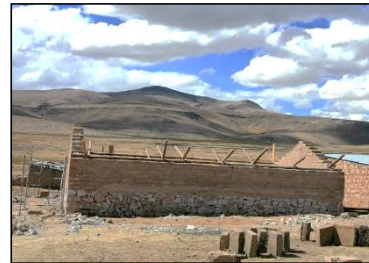
6 Estructura de techo
