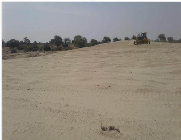
Foto N° 01: Acondicionamiento del terreno Nivelación
